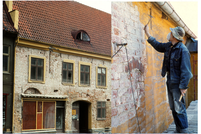
Byggnadsarkeologi Niels Kuntzes hus Malmö museer
